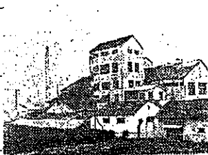
茨城県石岡の政府専用 アルコール工場
